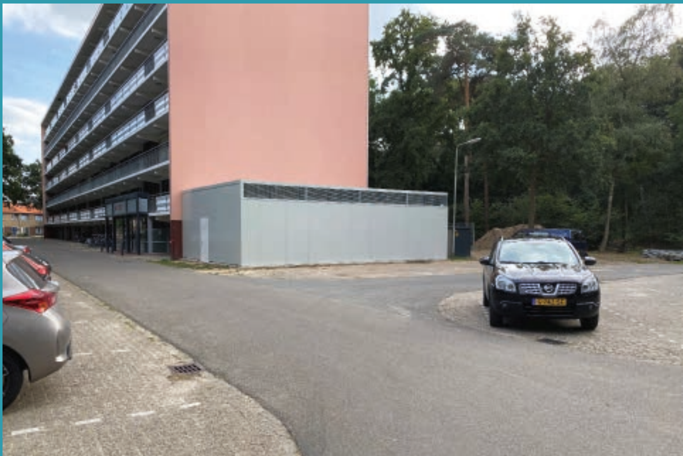
Het in Venray geïnstalleerde systeem is opgebouwd uit twee warmtepompunits van 250 kW, die elk zelfs bij een buitentemperatuur van min twintig graden in twee stappen nog steeds water van tachtig graden kunnen leveren.
