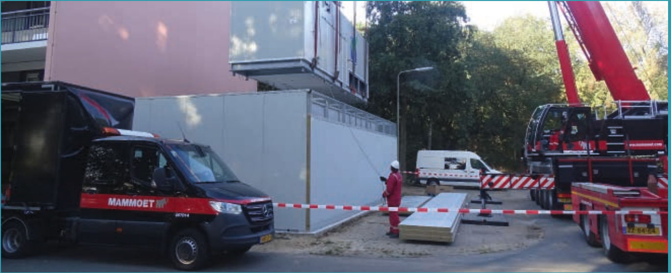
Na het installeren van de warmtepomp hebben de appartementen nu een energielabel C of B, afhankelijk van de situering in het gebouw.
