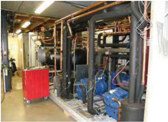
Samenbouw en montage van een chiller met 650 kW koelvermogen in de werkplaats van Servex.
